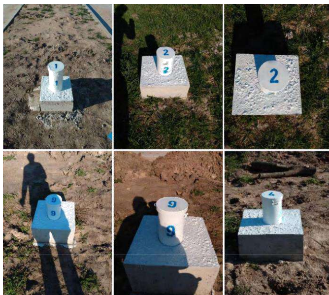
Figura 3. Diseño constructivo del brocal de protección de las perforaciones de monitoreo
